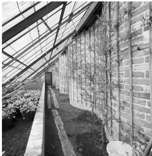
Greenhouse built against a serpentine fruit wall. Source: Rijksdienst voor het culturele erfgoed .
